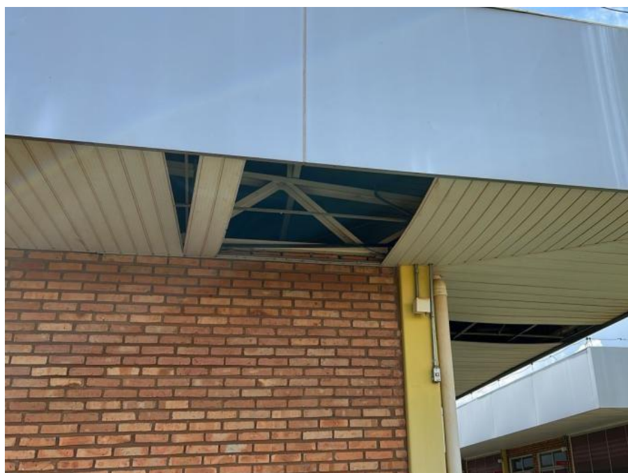
Imagem 02: Bloco C, recomposição de forro em réguas de PVC.
