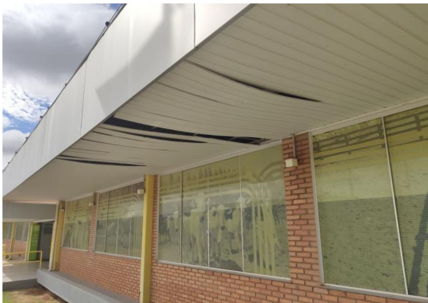
Imagem 01: Bloco A, recomposição de forro em réguas de PVC.
