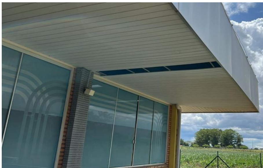
Imagem 02: Bloco C, recomposição de forro em réguas de PVC.
